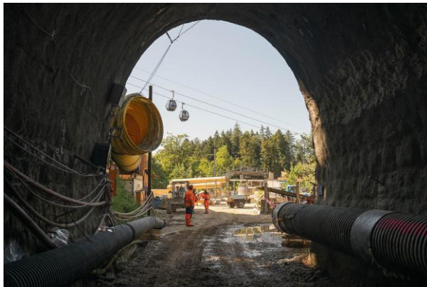
Blick aus der Tunnelröhre Foto: BLS/Simon von Gunten
